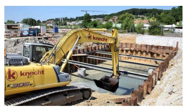
Schaufel für Schaufel wird das belastete Erdreich ausgegraben aus der mit Spundwänden gesicherten, rund 7 Meter tiefen Grube. mhu
